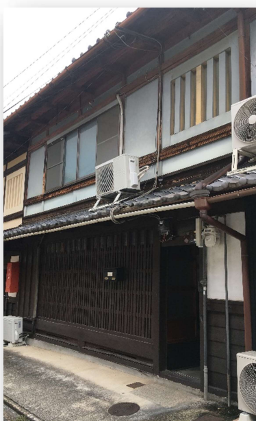
改修前の外観
