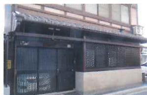
【再生前外観】玄関の左側がガレージ
