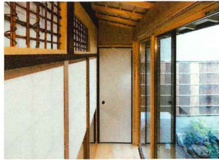
増築されていた縁側を元の形に戻す際、小舞天井に変えている
