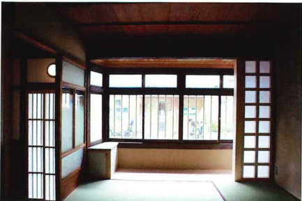
和室 補強を兼ねた格子状の壁を増設(写真右側)
