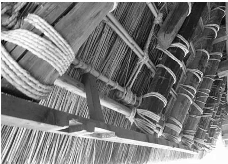
建物は小屋梁までは他の建物と同じように建てますが、通常の建物では母屋木と束・垂木で屋根下地を組むのを、茅葺では丸太を合掌に組み母屋木を（多くは竹で）この丸太にくくりつけていきます。
