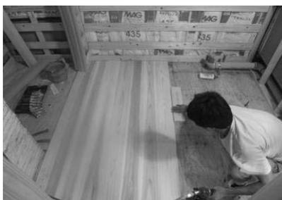
洗面脱衣室等は荒壁のみでは断熱が足りないので、大壁にして断熱材（グラスウール）を入れます。床は、下張りの上に杉板のフローリングを張ります。
