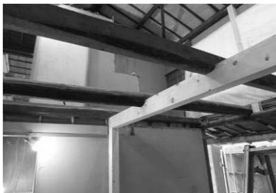
屋根を直して、次に2階の部屋にも浴室を造るので、2階床を補強しています。
