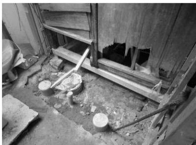
屋根も瓦が割れて雨が室内に大量に漏れており、屋根から直します。室内も壁があちらこちらと落ちています。
