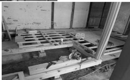
2階の床が張れたら、1階も床組み後、床張り作業を行います。
