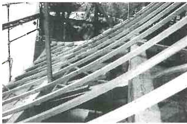
これで荒野地を張っていきます。反りの曲がりに合わせて野垂木を順次取り付けていきます。破風の部分は少し勾配になるので野地板もこれに併せて張り上げていきます。
