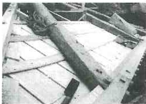
化粧野地を張る前に一度シートを外し全体のバランスなど見渡せるようにして確認します。四方共見て行きます。
