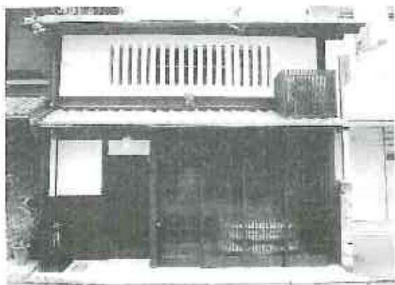
外観です。中2階の窓は元の虫籠窓に戻しました。玄関も造り直し、ガレージも内部に設けました。
