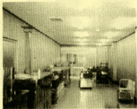
2F倉庫です。壁はモルタルシゴキ仕上、天井は鉄骨のデッキプレート塗装仕上、床はコンクリート金鑛仕上です。床からの湿気を吸上げないように通路以外のスペースにスノコを敷きました。
