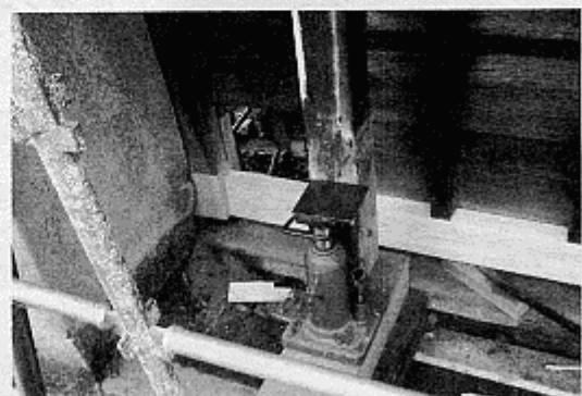
最近、改修現場においても、出来るだけ古い柱や梁を残して、補修や修繕にて再使用を行なう工事がふえています。新しい材料と取替えるのが早くて楽なのですが、歴史を感じる建物にはそういう手法は最終手段として行うべきで、それまでは修理修繕にてとしています。これも古材の活用の1つと考えています。
