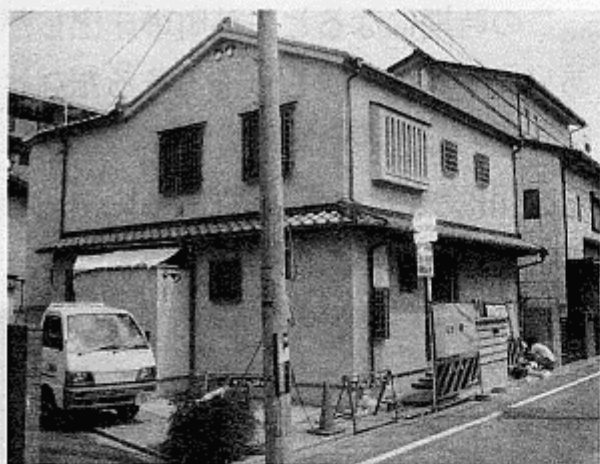
道路からの全景
