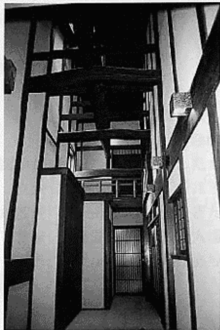
H邸玄関ホール
