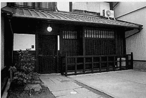
H邸外観/改修後
